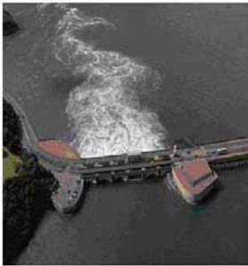
Potvynių ir atoslūgių elektrinė
